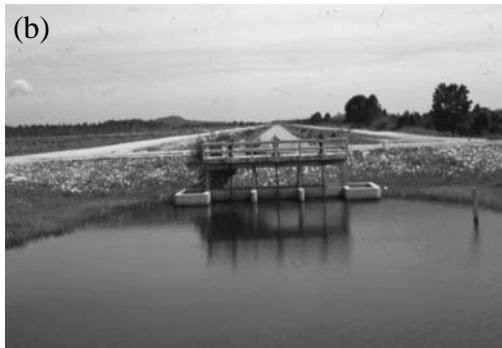
図2. 大規模排水用水路。(a)排水路設置のために伐採された二次林と排水路。(b)水位調節のための水門。
