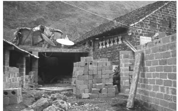
写真13 石灰岩から作られるブロックで新しい家屋が次々とたてられている。
