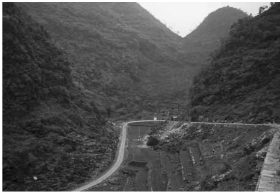
写真9 この道路は日本側の援助(外務省)で敷設されたが、中国の資金によって他の村落にも急速に道路は普及した。山の中腹にある軍用道路から各村落に道がひろがっている。
